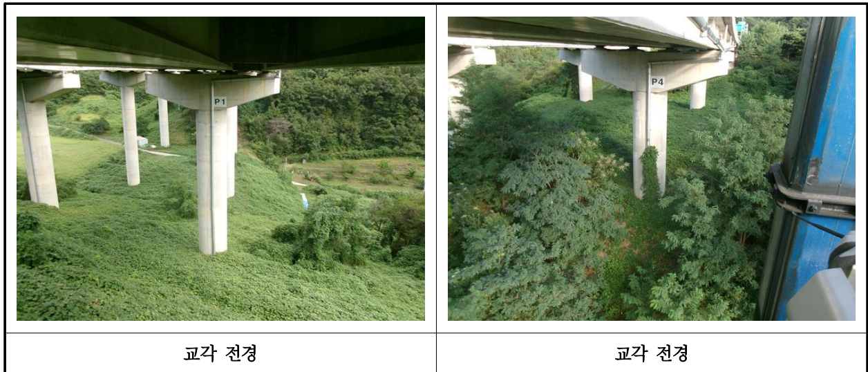
【사진 13.3.35】 교각 전경
