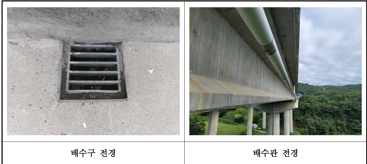
【사진 13.3.47】 배수시설 전경
