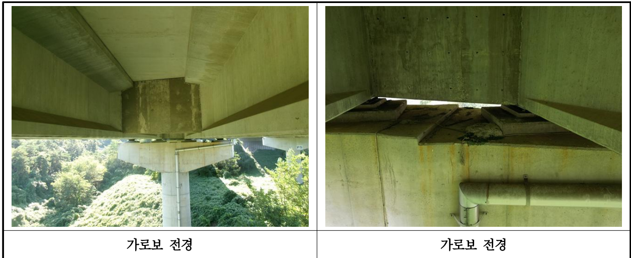
【사진 13.3.6】 가로보 전경
