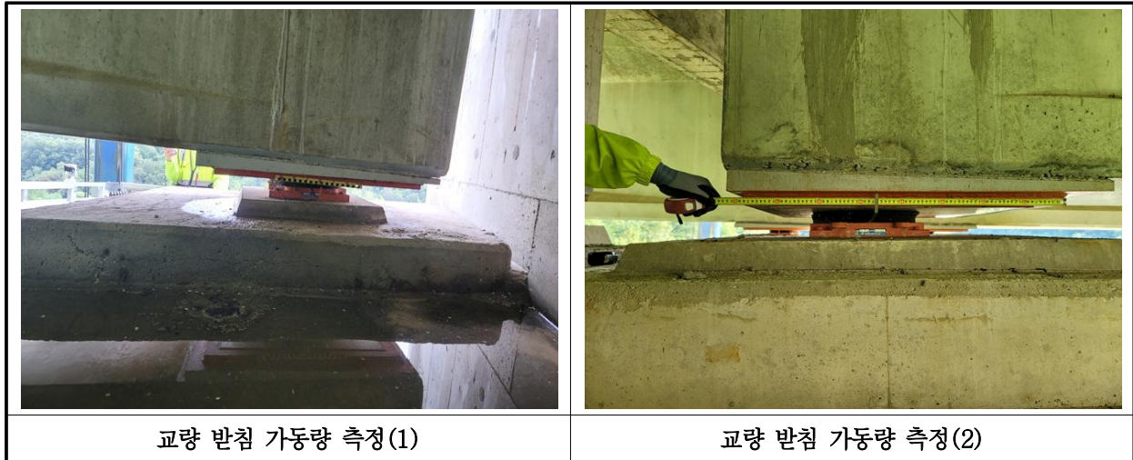
【사진 13.3.41】 교량받침 이동량 측정
