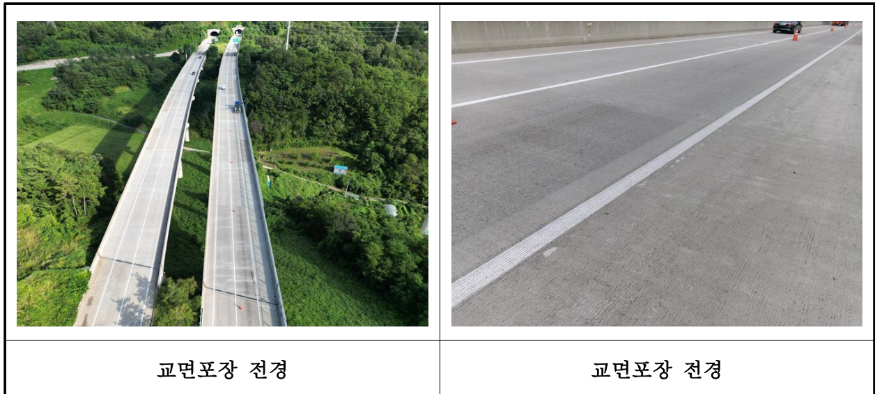
【사진 13.3.45】 교면포장 전경
