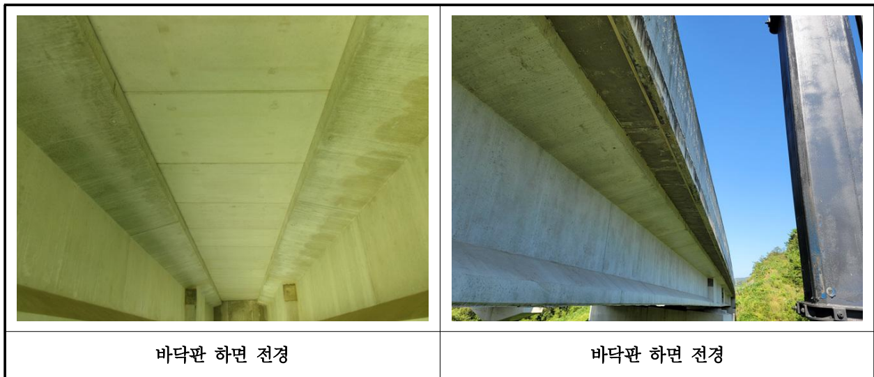
【사진 13.3.2】 바닥판하면 전경
