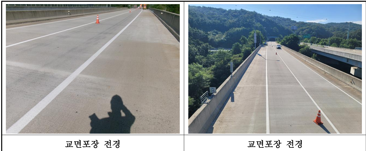
【사진 13.3.20】 교면포장 전경
