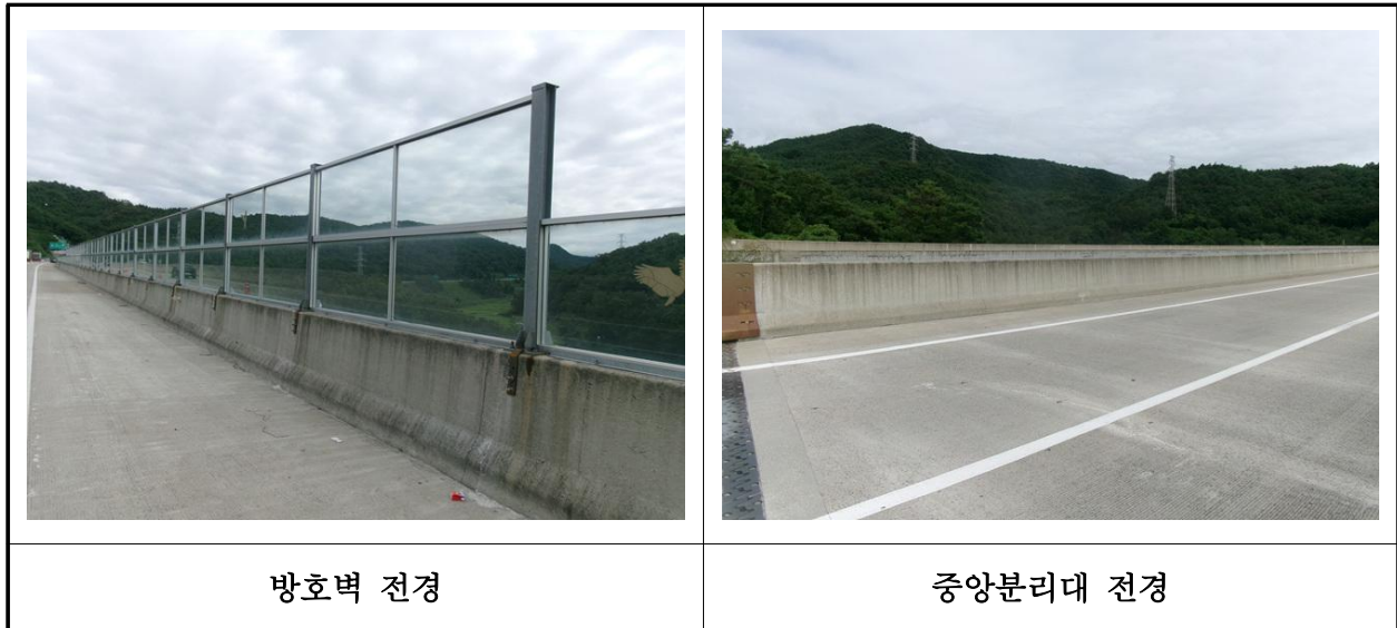
【사진 13.3.49】 방호벽 및 중앙분리대 전경
