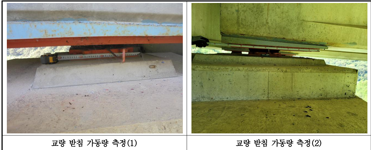
【사진 13.3.16】 교량받침 이동량 측정
