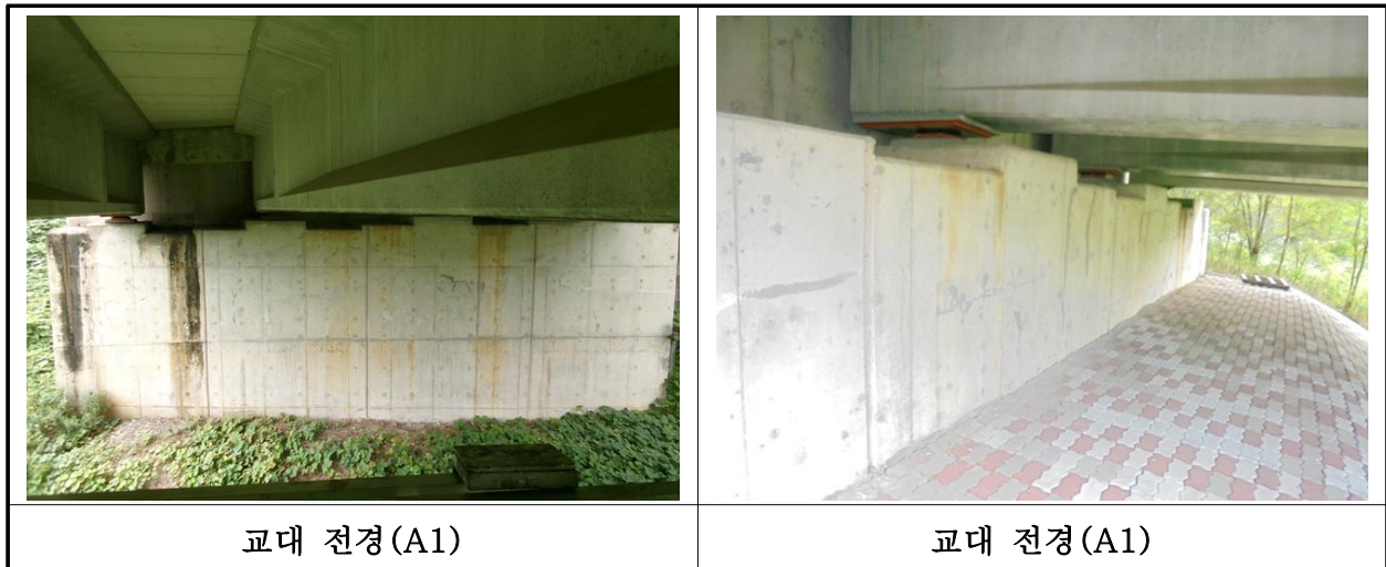
【사진 13.3.33】 교대 전경
