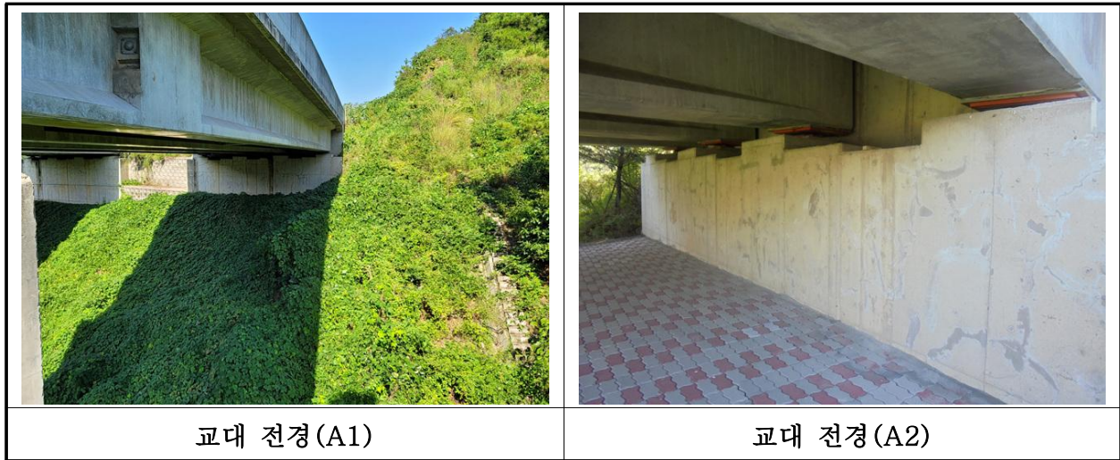
【사진 13.3.8】 교대 전경
