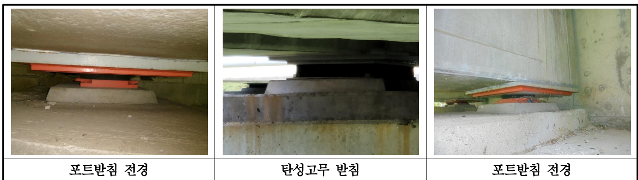
【사진 13.3.38】 교량받침 전경
